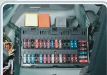
Caixa de fusíveis na central do painel
