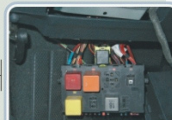
Caixa de relés, localizada acima dos fusíveis
