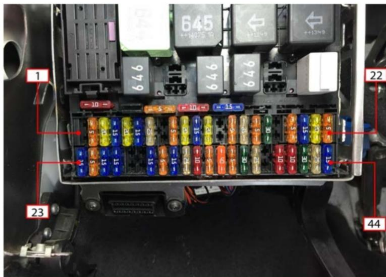
Central de fusíveis e relés do painel
